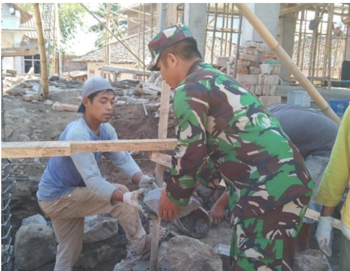
Serda Nasikin bantu pemasangan batu pondasi masjid
